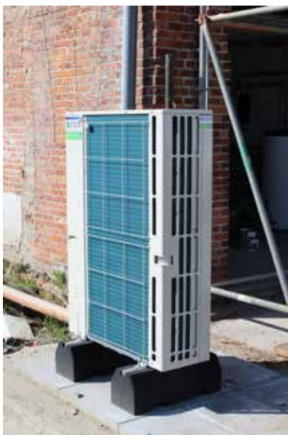
L'unité extérieure est le Zubadan Inverter. Celui-ci peut chauffer jusqu'à -15°C sans perte de puissance. Tout chauffage d'appoint se révèle donc superflu.
